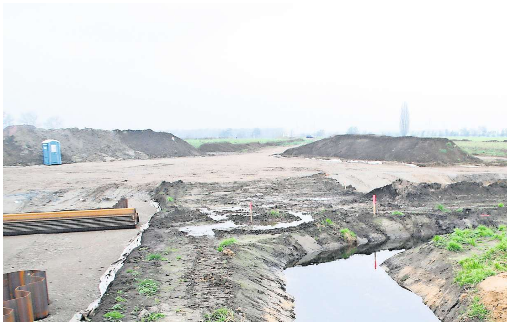
Baustelle zwischen Arnum und Ohlendorf: Hier wird später einmal ein Abschnitt der B-3-Ortsumgehung sein.
